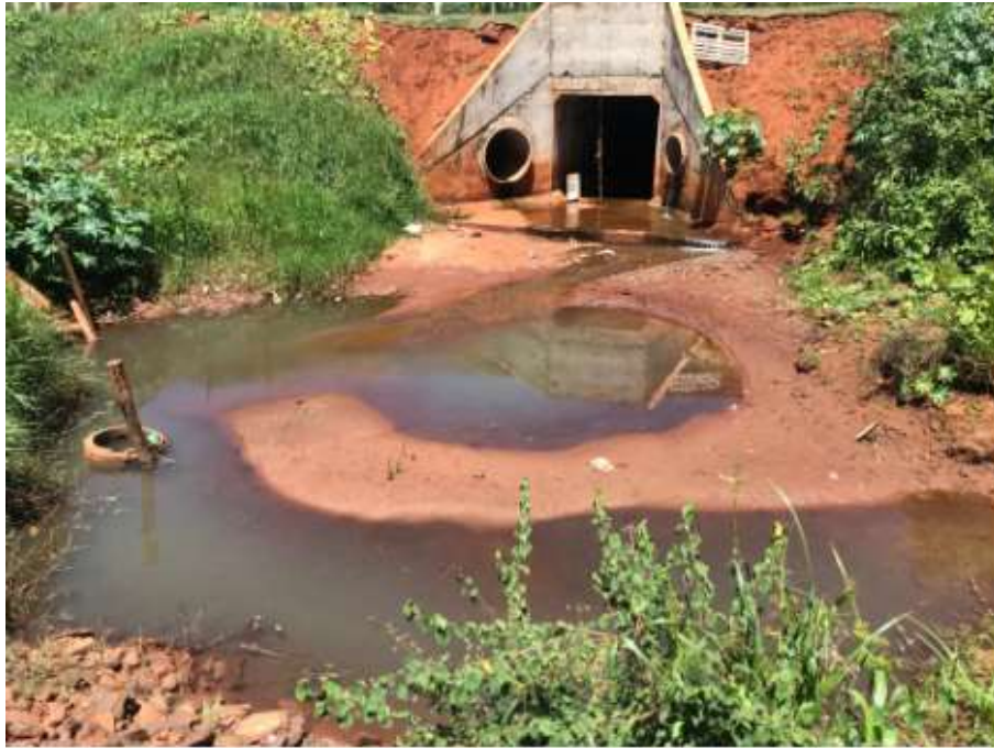
Figura 9 - P4 na campanha de monitoramento C3. Fonte: Autora, 2022.
