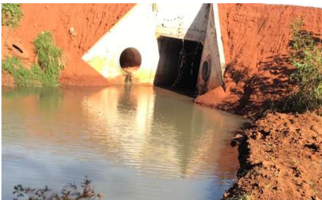
Figura 8 - P4 na campanha de monitoramento C1. Fonte: Autora, 2022.
