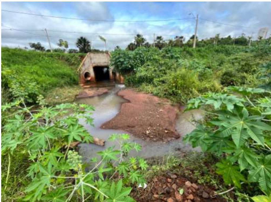
Figura 10 - P4 na campanha de monitoramento C6. Fonte: Autora, 2023.
